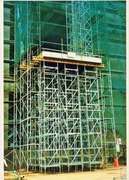
荷上げ構台施工例
