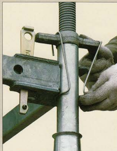
⑦セーフティストラップでヘッドスピンドルを固定します。
