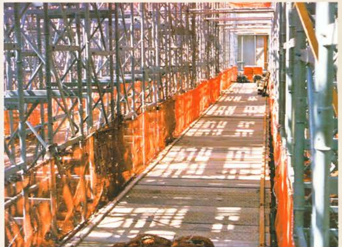
広く確保された通路
