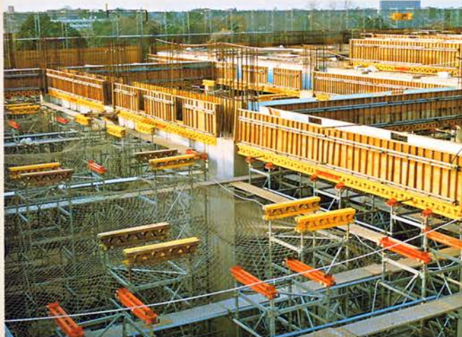
物流センター梁下支保工設置状況
