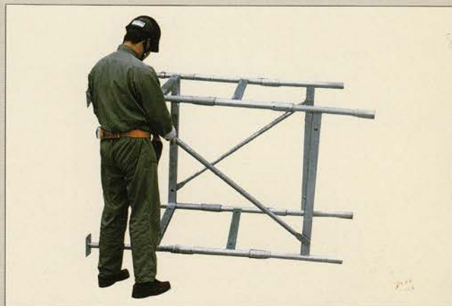
②スタッキングフレームを対面する2構面ずつ差し込み、ダイアゴナルストラットを取り付けます。タワーの必要高さまでこの作業を繰り返します。
