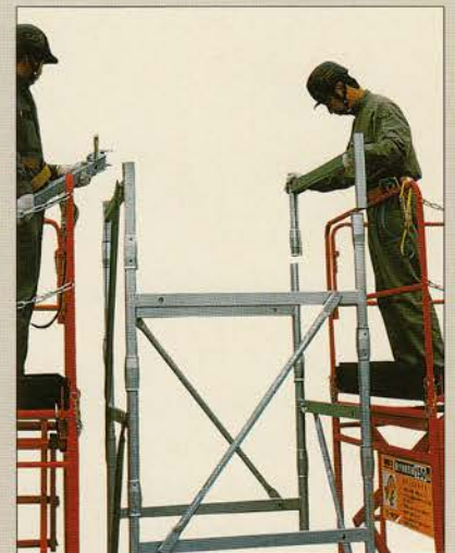
⑤エンドフレーム、エンドサポートを差し込みます。
