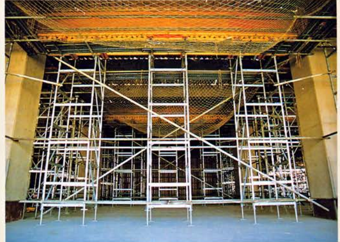
物流センタータワー支保工Ⅲ施工例
