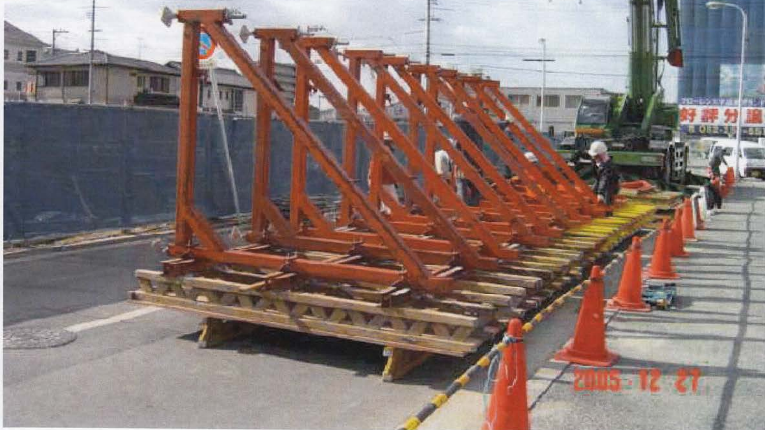
ブレースフレーム・スピンドル設置後
