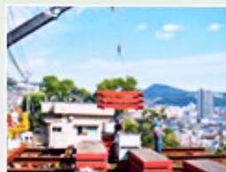
覆工板を搬入
