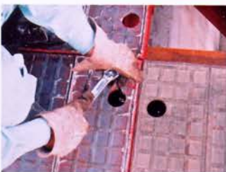
本締めにて覆工板固定金具とH鋼が一体化
