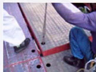
覆工板固定金具とH鋼が一体化
