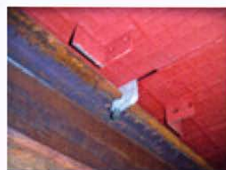
H鋼と覆工板とが固定金具にて一体化した裏面
