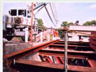
覆工板固定金具取付前
