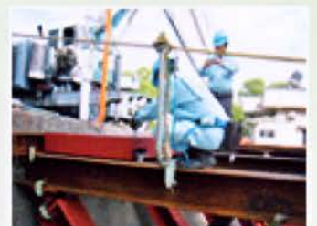
1枚目の覆工板を位置決めて設置する
