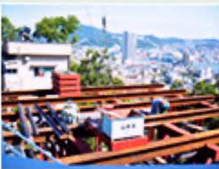
覆工板施工現場
