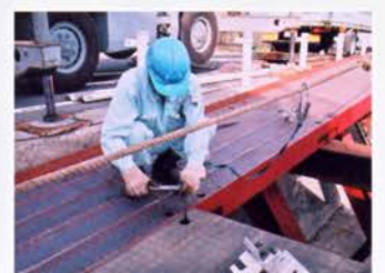
覆工板固定金具のBボルト2ヶ所を締付けH鋼と固定する
