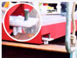
覆工板固定金具とH鋼が一体化
