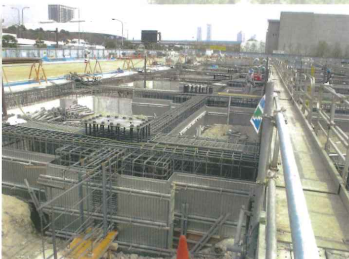
埋戻し部のフーチン・地中棟梁に使用Ⅰ
