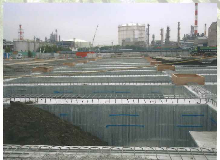
埋戻し部のフーチン・地中棟梁に使用Ⅱ
